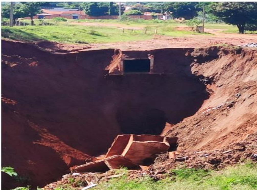
Macro drenagem em processo de destruição.
